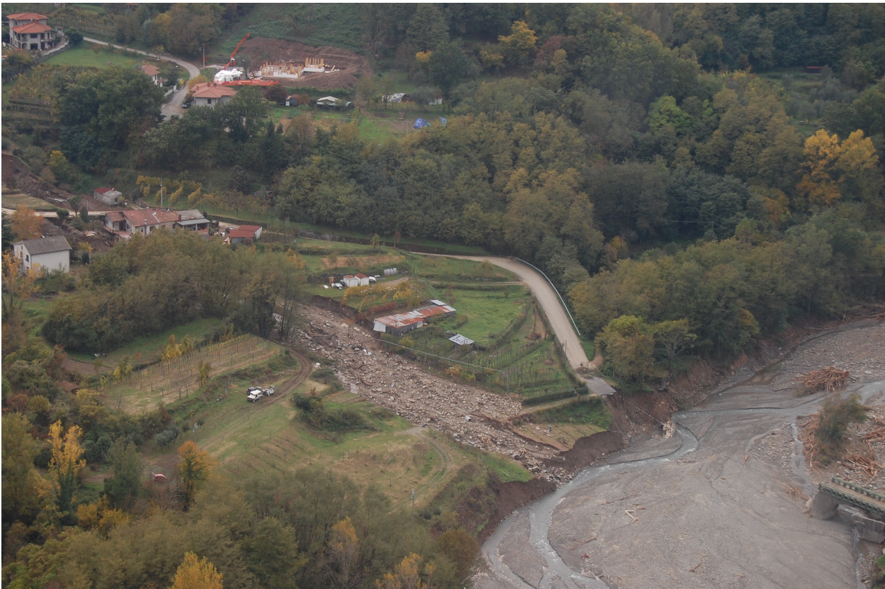
Torrente Mangiola – Ponte distrutto dalla piena sulla SP 32 (ore 16:05 del giorno 2 Novembre 2011).
