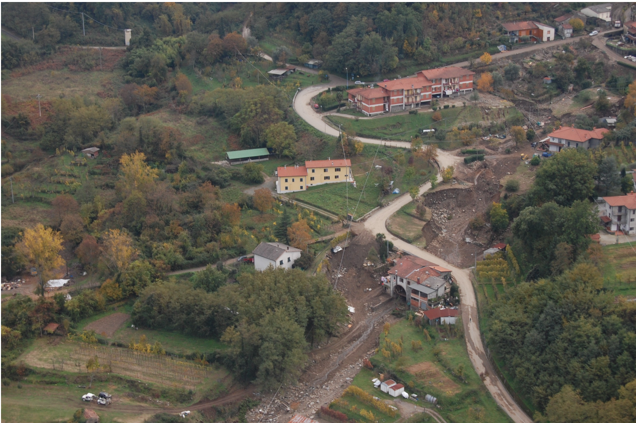
Torrente Mangiola – Ponte distrutto dalla piena (ore 16:07 del giorno 2 Novembre 2011).
