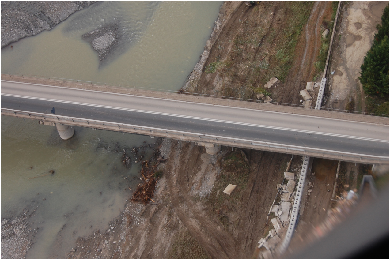
Fiume Magra ad Aulla. Particolari delle rotture del muretto (ore 17:07 del giorno 2 Novembre 2011).
